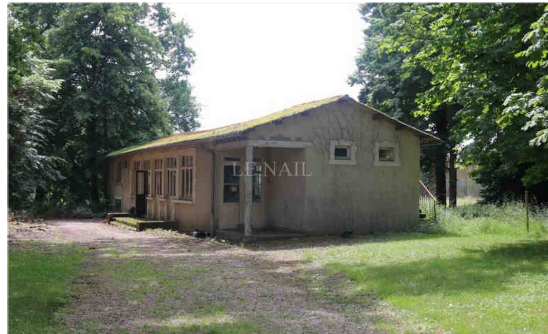
LE BATIMENT A USAGE DE REMISE
